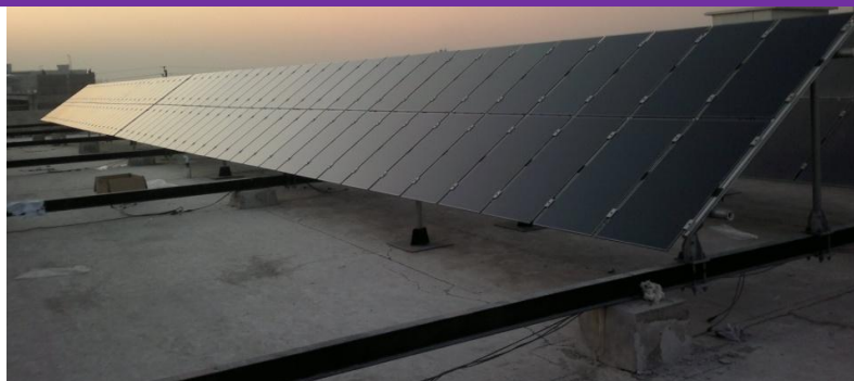
13KW a-Si/a-SiGe/ \mu c-Si solar module PV station
